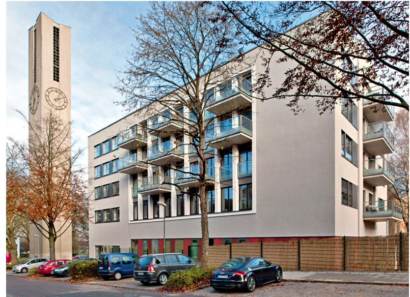
Um der Wohnnutzung in den Obergeschossen gerecht zu werden, wurden neue Fenster und Balkone installiert. • In order to meet the requirements of the residential use, new windows and balconies were added.
