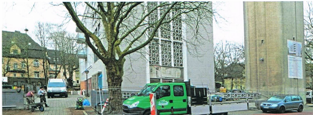
Derzeit pflastern Arbeiter den Vorplatz der ehemaligen Lukaskirche an der Planckstraße.
